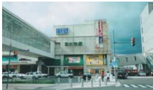
駅舎と自由通路
